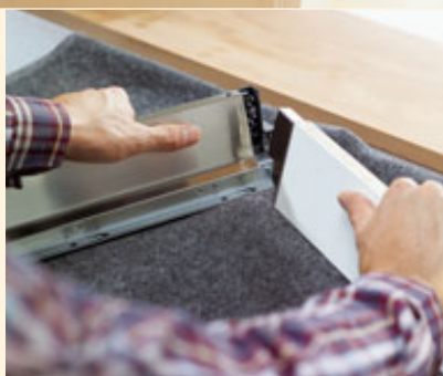
Простое соединение царг и задней стенки
